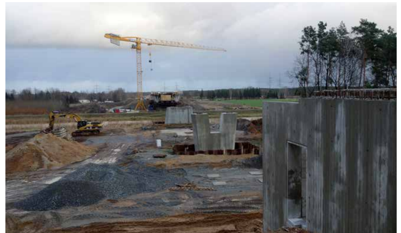
~ BW 06, Bauzustand Dezember 2016
